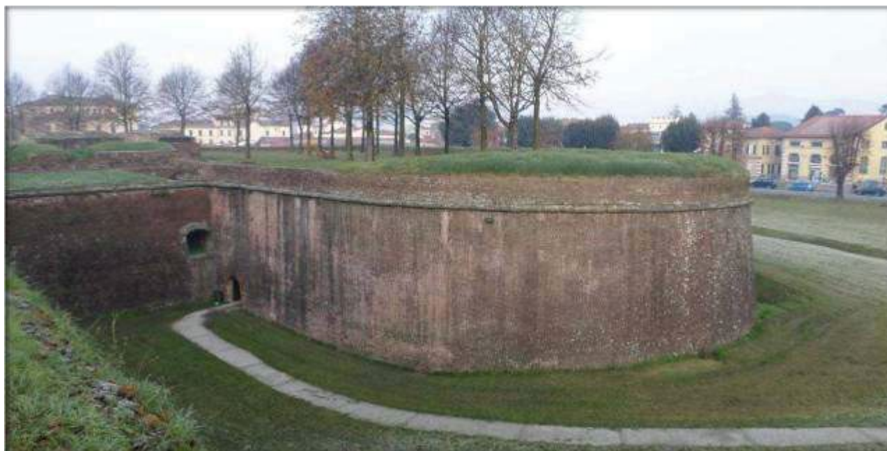
Baluardo San Colombano
