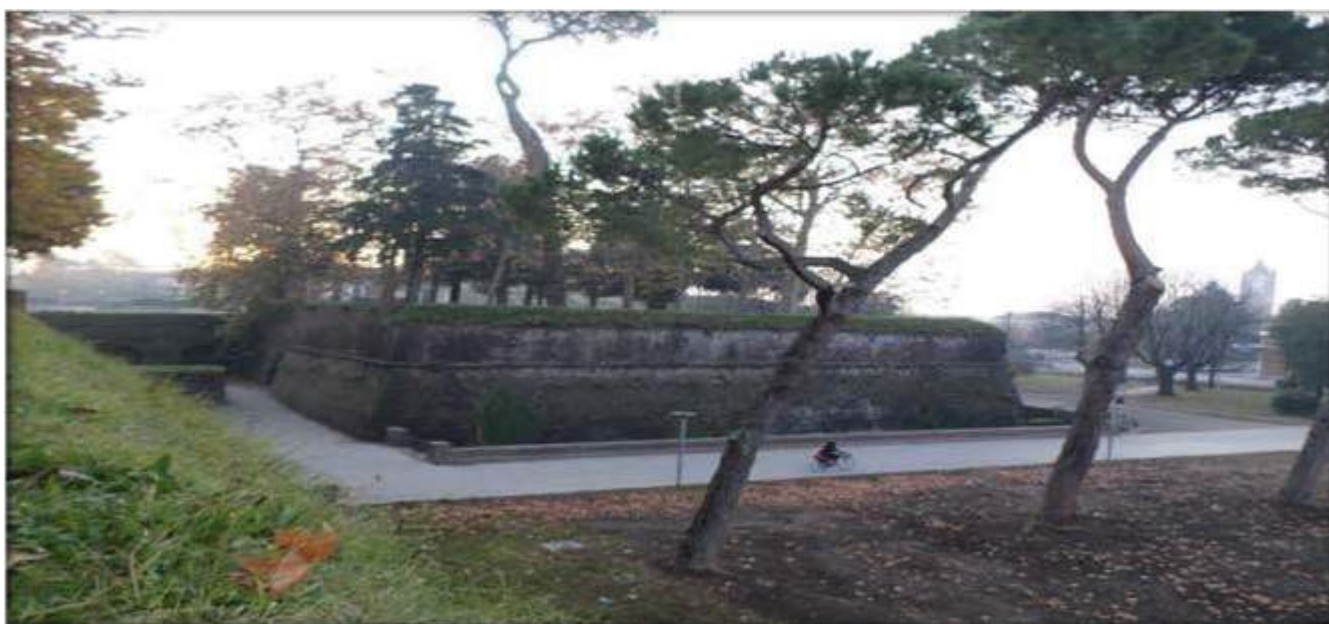
Baluardo Santa Maria
