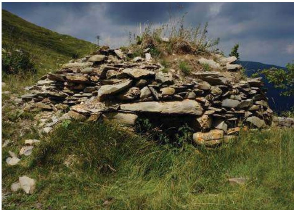
“Casella”, antica abitazione-deposito rurale costruita con pietre a secco, nella località Pantestina. Questi rustici agricoli erano ubicati nei luoghi che, al momento del taglio del fieno, erano utilizzati per l’insediamento e per il ricovero degli attrezzi e del fieno stesso. Vedi GALLO 2011, p. 39.
