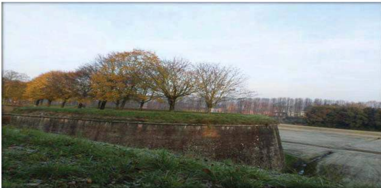
Baluardo San Donato nuovo
